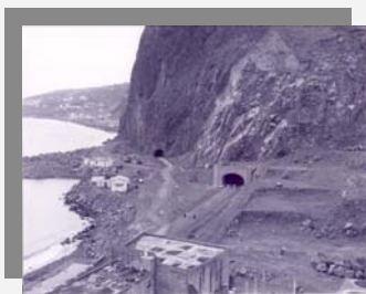
Túnel viejo y nuevo.
